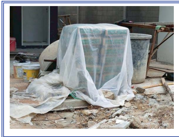
รูปที่ 3-6 ผ้าใบปิดคลุมวัสดุก่อสร้าง
