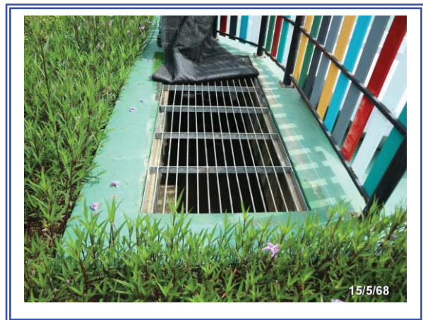
รูปที่ 3-12 ตะแกรงดักขยะ
